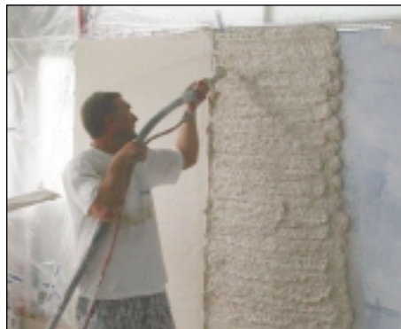
Aufbringen eines PCM-haltigen Gipsputzes im Neubau des Fraunhofer ISE
