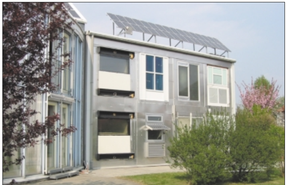
Fassadenteststand des Fraunhofer-ISE: außen links übereinander die beiden Testzellen in Leichtbauweise.
